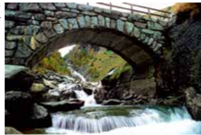
Alt und archaisch: Brücke über den Umbalbach, dem Oberlauf der Isel in Osttirol
